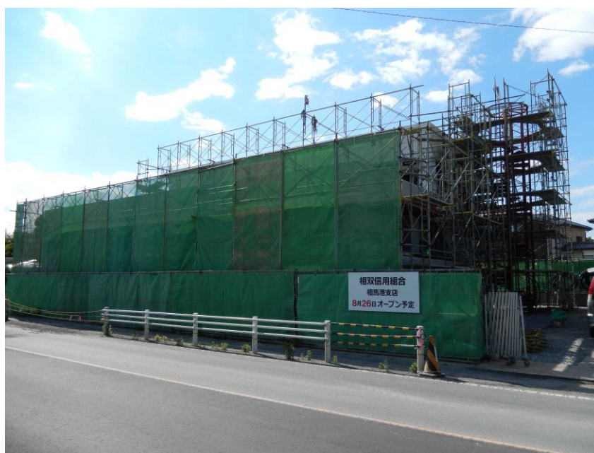
平成 25 年 6 月現在「相馬港支店」建築状況
