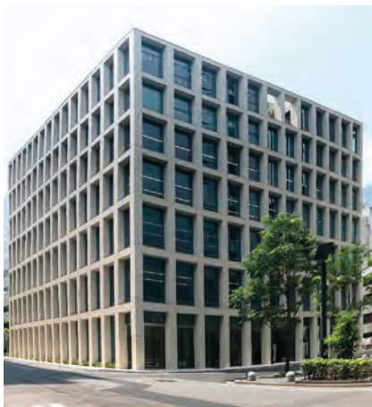
新「全国信用組合会館」2019年7月31日竣工
