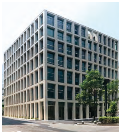
新「全国信用組合会館」2019年7月31日竣工
